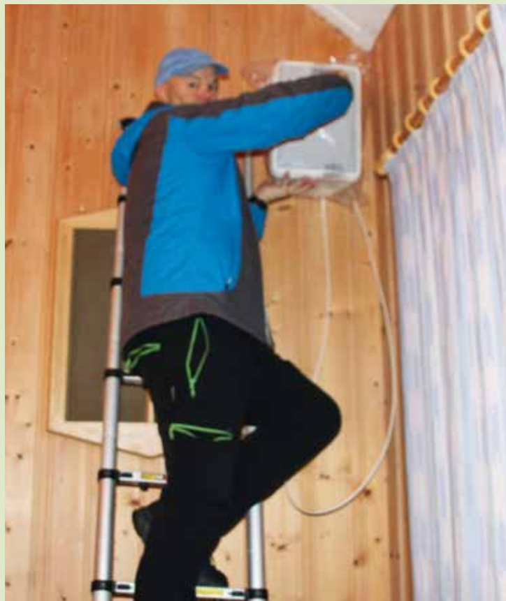
Ole Hansen monterer høyttalerne på veggen omtrent der de gamle stod. De nye er også hvite.
